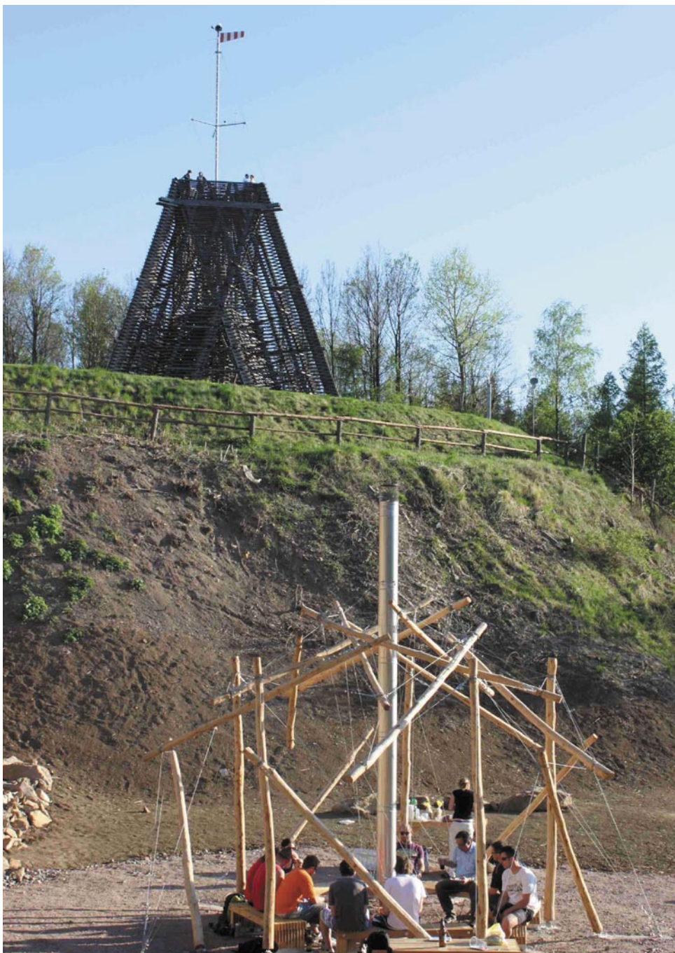
Typická a unikátní konstrukce rozhledny Báry je vyrobena z modřínového a dubového dřeva z chrudimských městských lesů. V popředí neobvykle řešené kryté ohniště tvořené dubovými kmeny a ocelovými lanky.
